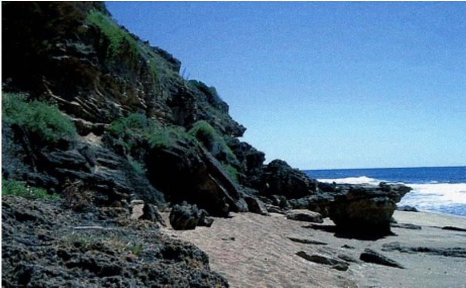
Fenomeni di crollo nelle eolianiti lungo il tratto costiero.
