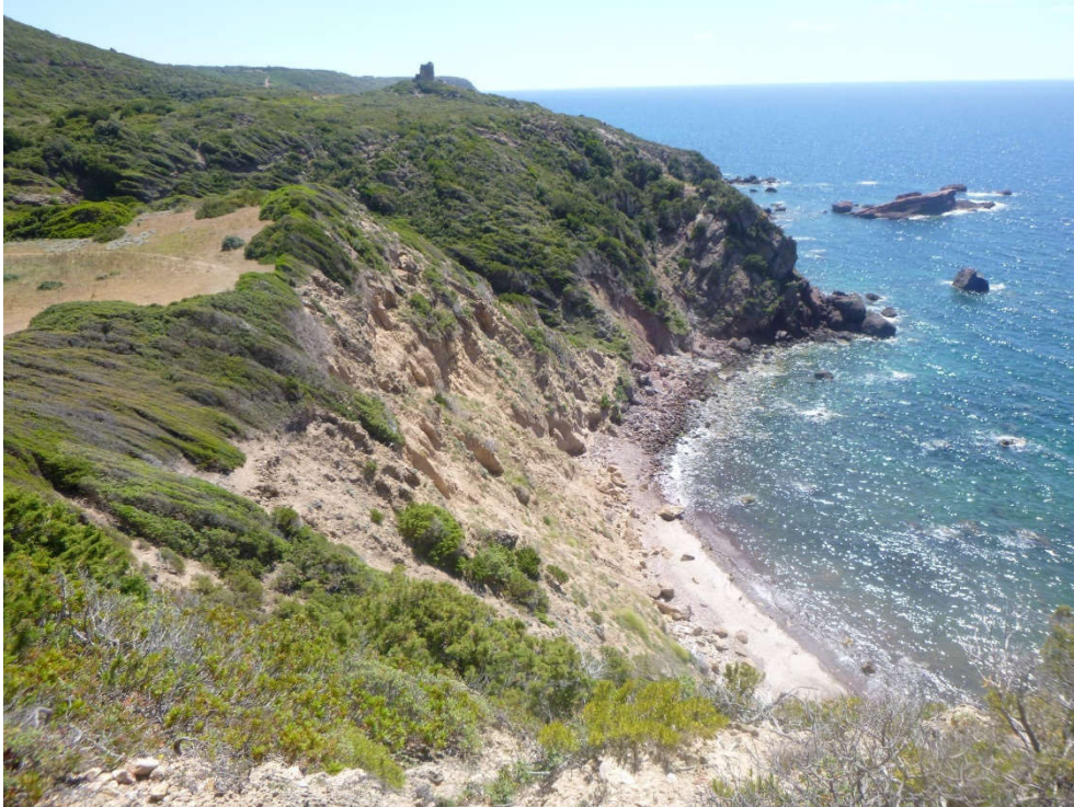
Figura 7-17 – Dopo qualche anno il corpo di frana che si osserva nella precedente Figura 7-16 è evoluto prevalentemente per azione di erosione al piede da parte del moto ondoso e progressivi smottamenti, si osservi, oltre la falesia modellata sulle arenarie eoliche, la nicchia di frana che interessa le litologie vulcanoclastiche mioceniche, inoltre è evidente la differenziazione che esiste tra la spiaggia sabbiosa che si origina dallo smantellamento delle arenarie e la spiaggia ciottolosa che si origina dai crolli sulle rocce vulcanoclastiche.
