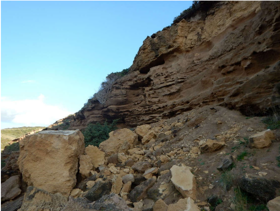
Figura 7-15 – Frana di crollo sulla costa a falesia del promontorio meridionale della spiaggia di Torre Columbargia, l'erosione del deposito colluviale posto alla base di un banco arenaceo più competente ha generato una morfologia a sbalzo che ha poi determinato il crollo di una porzione di ammasso mobilizzata su una discontinuità parallela al fronte della falesia, il fenomeno franoso è evidentemente attivo.
