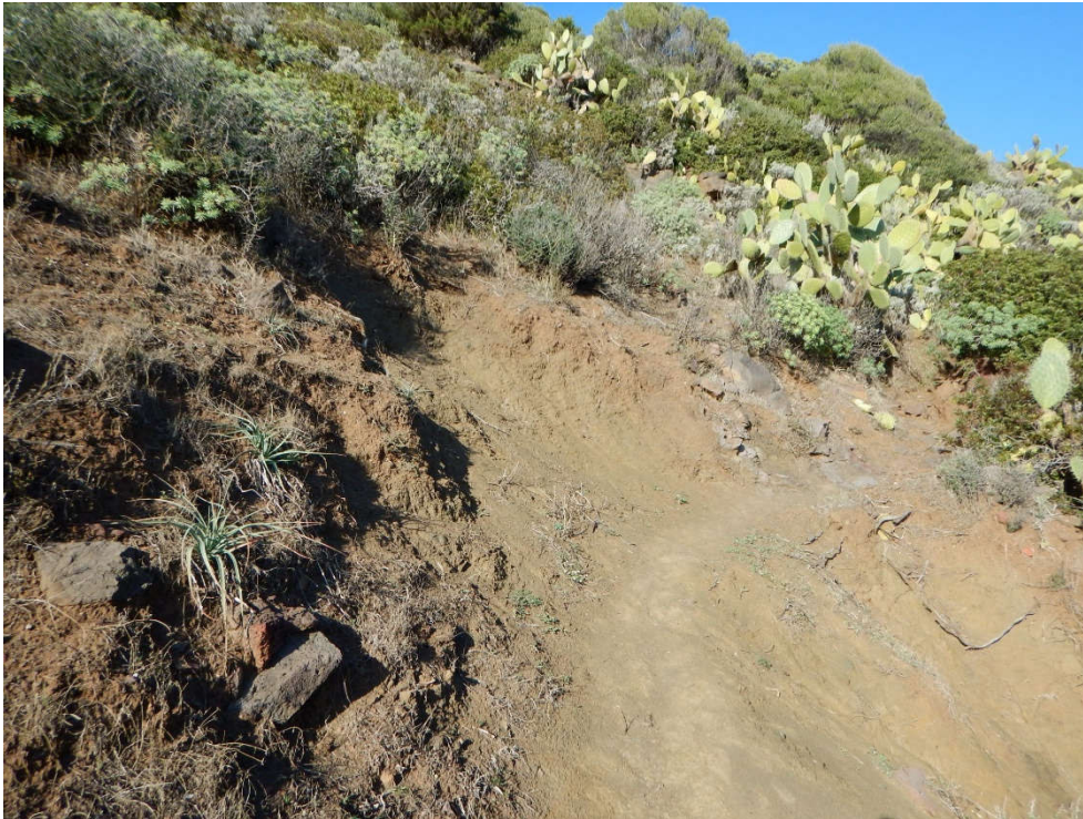
Figura 7-10 – Recente nicchia di distacco di una frana di crollo sulla destra del Riu Mannu, nei pressi della foce, la frana ha coinvolto i materiali detritici della copertura a monte di una cornice rocciosa, ma presumibilmente è stata attivata da un crollo di una porzione dell'ammasso roccioso sottostante su cui poggiava la coltre detritica e/o di alterazione.
