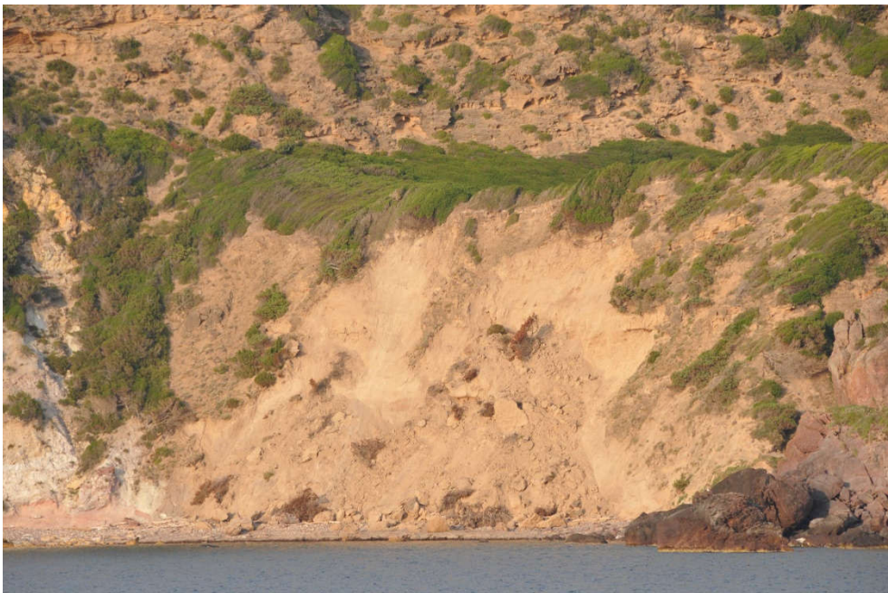
Figura 7-16 – Frana di crollo sulle arenarie pleistoceniche nella falesia a nord di Torre Ischia Ruggia, in questo settore le arenarie non presentano una evidente stratificazione e si presentano omogenee nell'addensamento e da punto di vista granulometrico, a valle di questo tratto di falesia, compreso tra affioramenti di rocce vulcanoclastiche è presente una piccola spiaggia appunto alimentata dai crolli della falesia.
