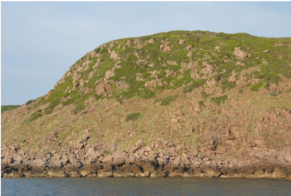
Figura 7-19 – Versante costiero complesso conformato sulle litologie ignimbriche di flusso piroclastico del Miocene inferiore, si osserva chiaramente la predisposizione degli ammassi rocciosi fratturati e disarticolati a frane di crollo e rotolamento, la falda detritica alla base mostra le importanti dimensioni degli elementi che vengono mobilizzati dalle frane.
